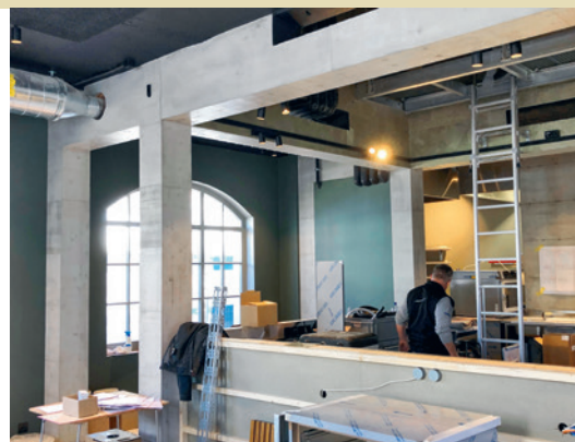
Noch ist Bauphase beim Tramhüsli.
